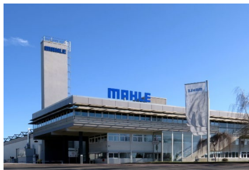
Wichtiges Etappenziel seiner CO 2 -Roadmap erreicht: Seit Ende 2021 sind alle deutschen MAHLE Fertigungsstandorte bezüglich Scope 1 und 2 Emissionen CO 2 -neutral gestellt – im Bild das MAHLE Werk in Mühlacker
