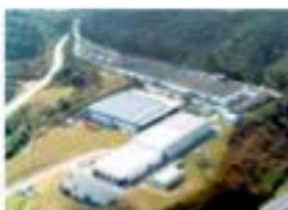
Arujá/SP Ar Condicionado, Radiadores, Condensadores Módulos de Refrigeração.
